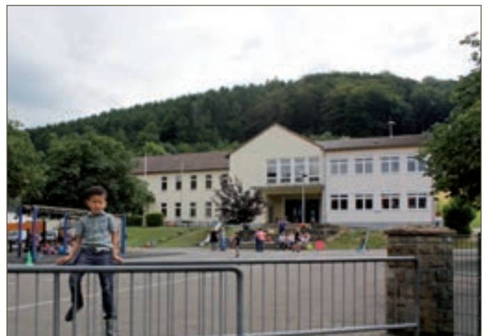
Oesetalschule (Grundschule) in der Oesestraße
